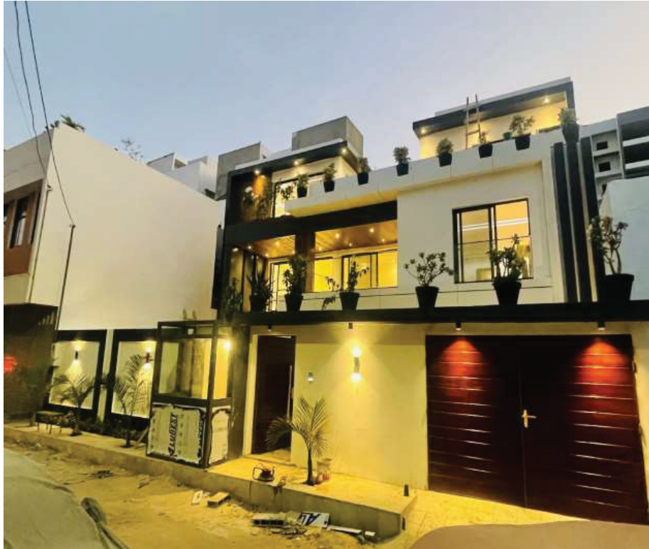
Villa RDC+2 étages Cité Touba renaissance
