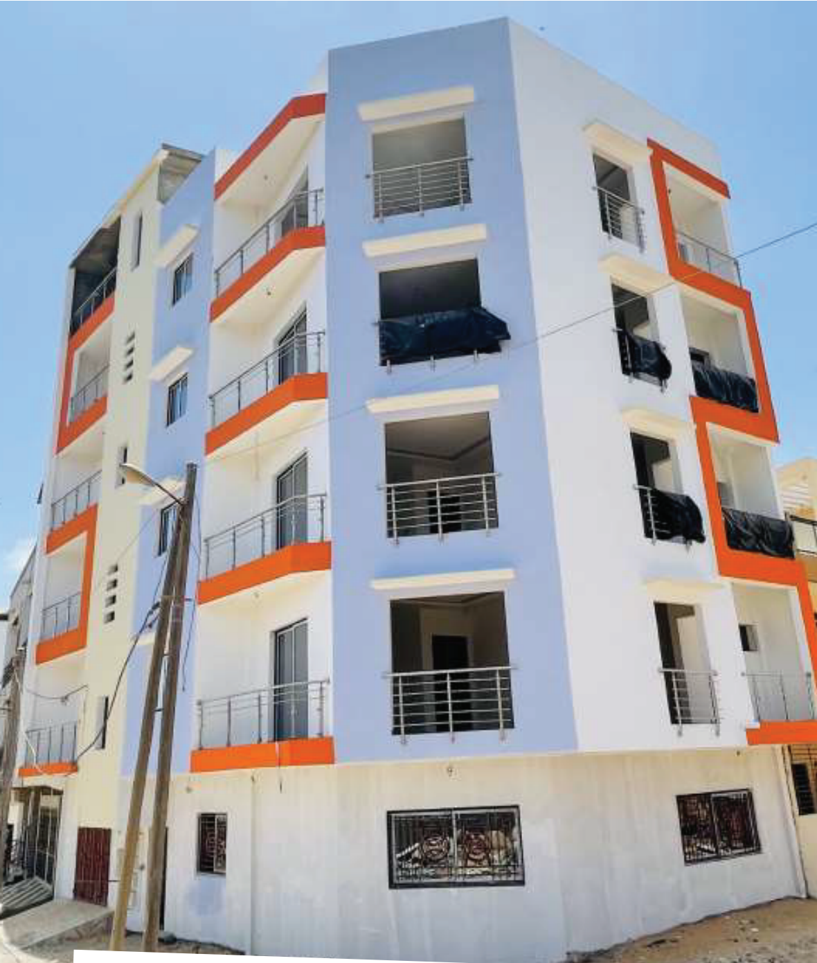
Immeuble RDC+4 étages Cité Batrain
